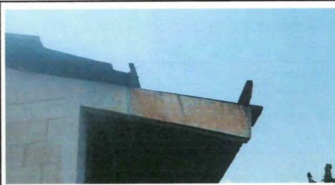
Foto 2: Cambio de techo por deterioro
