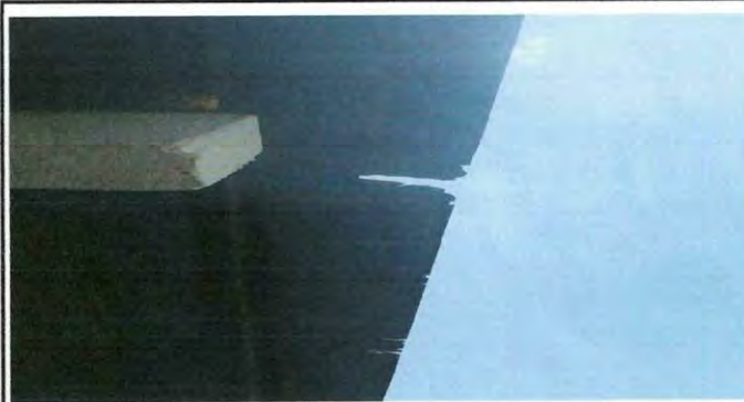
Foto 4: Cambio de techo por deterioro
