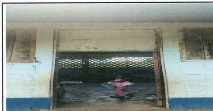
Foto 5: Elaboracion e instalacion de puertas de metal
